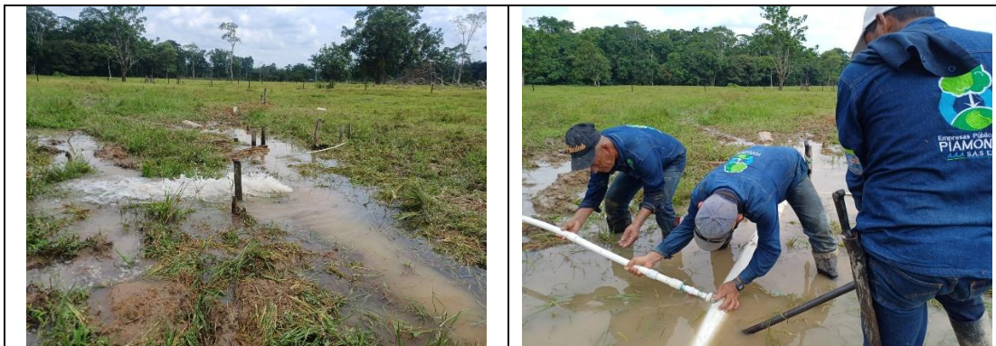
Trabajo realizado en zona del acueducto regional La Sonora, sector El Morro.
