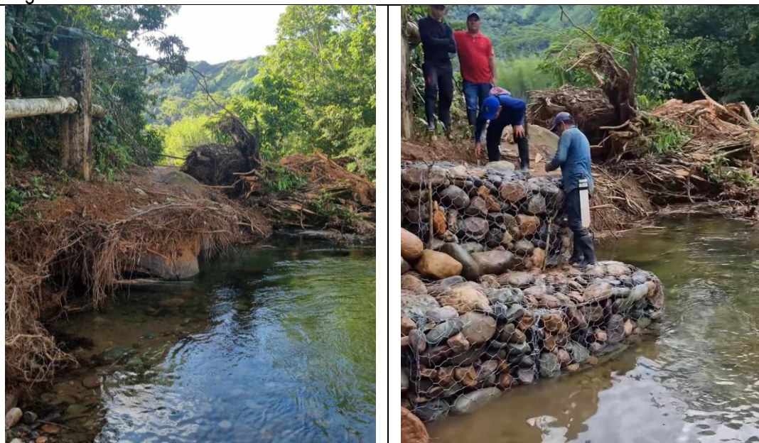
Gaviones construidos en sector viaducto del sistema acueducto Regional La Sonora.
