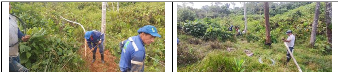
Trabajo realizado en el acueducto La Sevilla, sector veredas La Esmeralda, Cerrito y La Sevilla por afectaciones relacionadas con la ola invernal.
