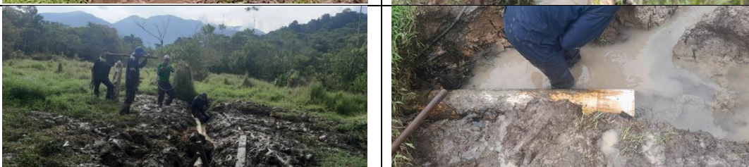
Arreglo en tubería de 8" acueducto regional.
