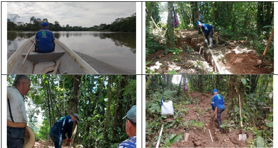
Desplazamiento y arreglo con guaya y tubería en el acueducto regional Sonora, sector de Angosturas.
